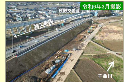
現地施工状況①
