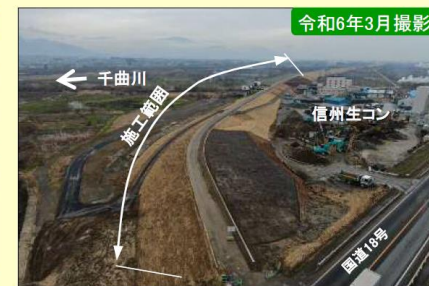
現地施工状況②
