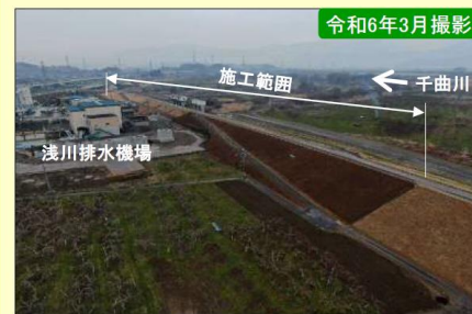
現地施工状況①
