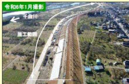
現地施工状況②
