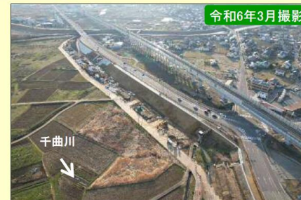
現地施工状況②
