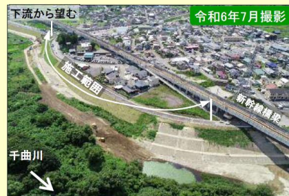
現地施工状況②
