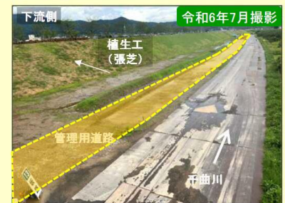
現地施工状況②
