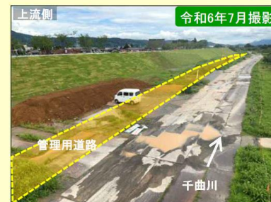
現地施工状況①
