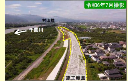
現地施工状況②
