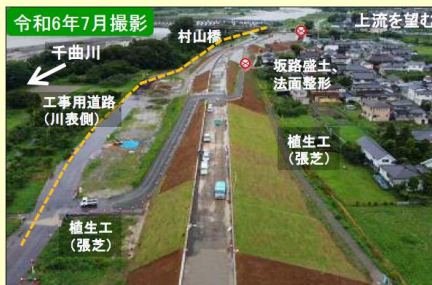
現地施工状況②
