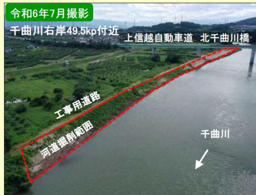
現地施工状況②
