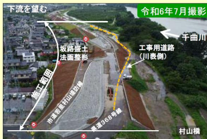
現地施工状況①
