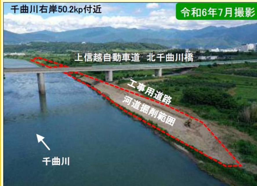
現地施工状況①
