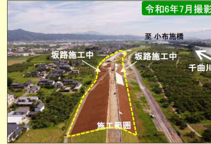
現地施工状況①
