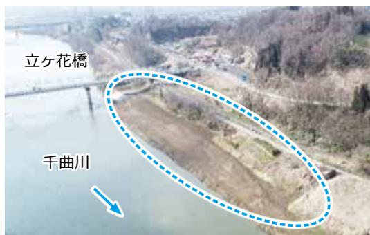
千曲川本川の水位低下を目指し、河道掘削を段階的に進めています。川底を下げ、堤防内の流量を増やすことにより、水害時のリスクが低下します。
