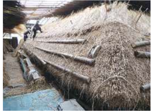
茅葺屋根の修理の様子
