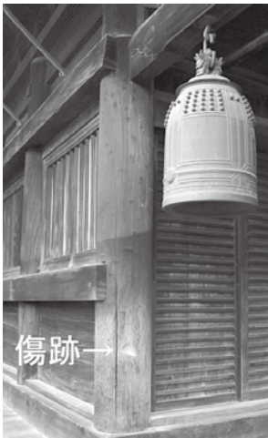
釣鐘が落ちた時の傷 (善光寺本堂西側の柱)
