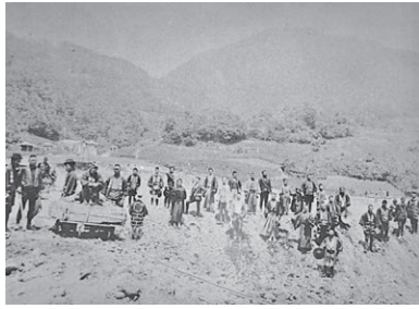
長野高等女学校 造成工事風景
