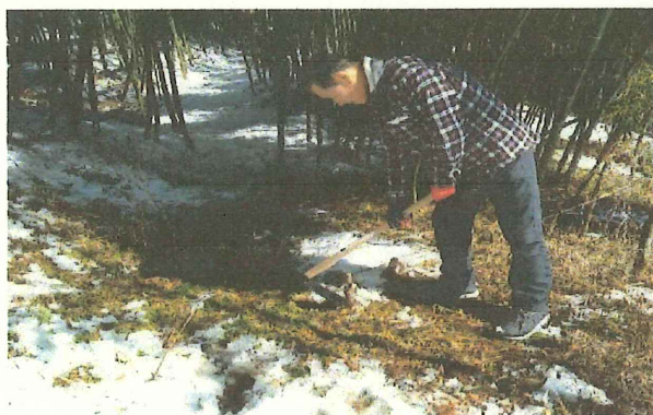
R7.3.20 林道内抜根作業
