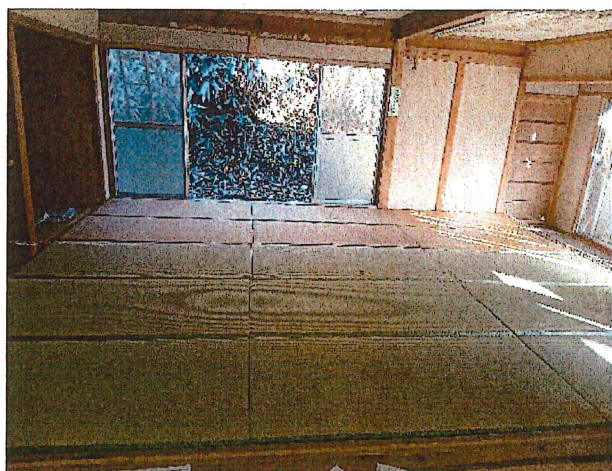
敷き込み完了
