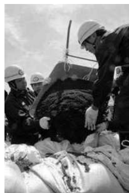
土のう積みの様子 14
