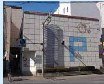
▲長野駅自転車駐車場
