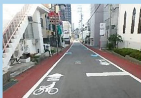
整備例 (箱清水石堂線)
