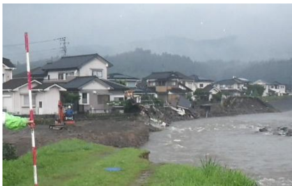
河岸侵食による家屋の倒壊(花月川)
