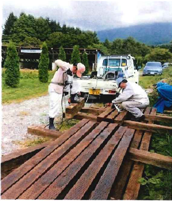
木枠の塗装と穴あけ
