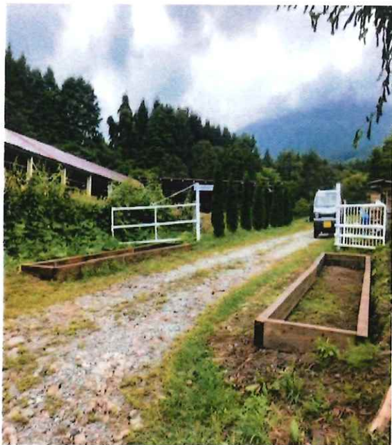
木枠設置完了
