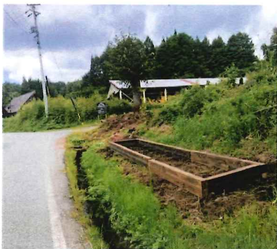
木枠設置完了
