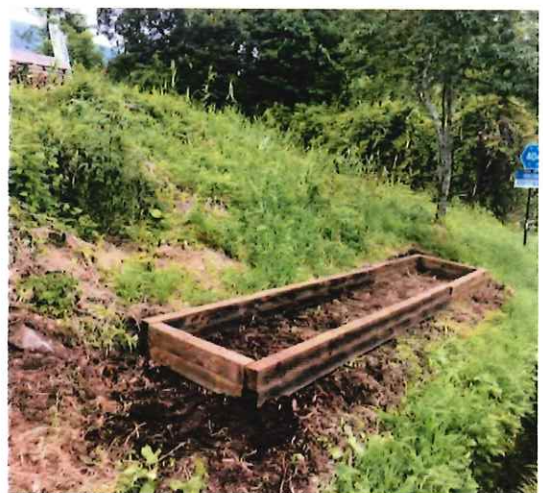
木枠設置完了
