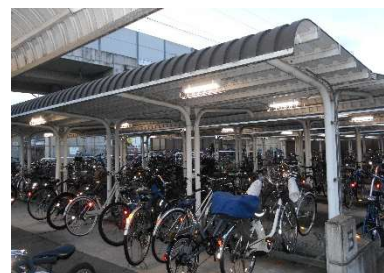
【照明LED化工事(川中島駅自転車駐車場)】
