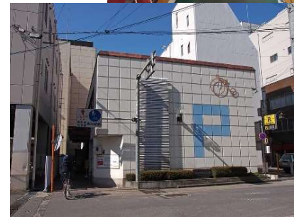
【長野駅自転車駐車場】
