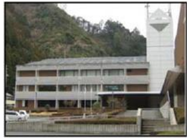
協働センター ※旧町役場・ホール
