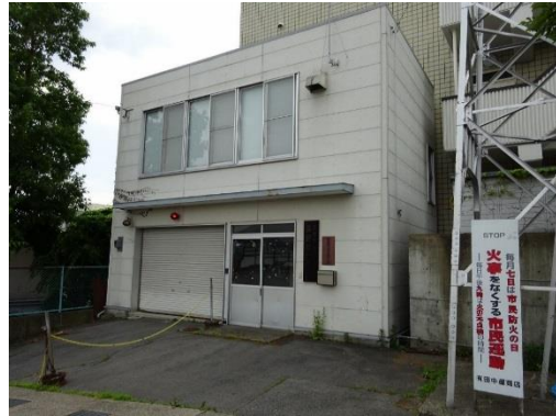
長野第一分団詰所【築35年】
