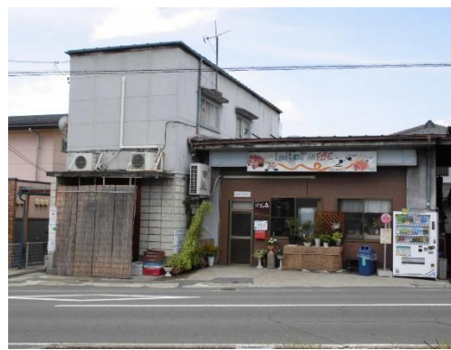
旧中央消防署桜枝町分署 【築52年】
