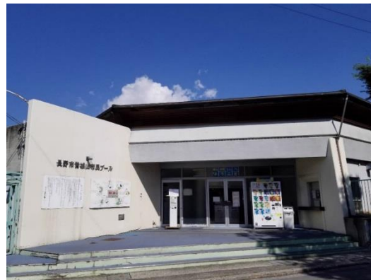
城山市民プール 【築45～47年】
