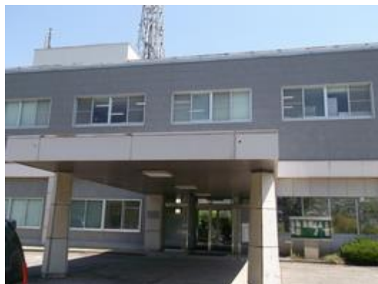
城山庁舎 【築56年】
