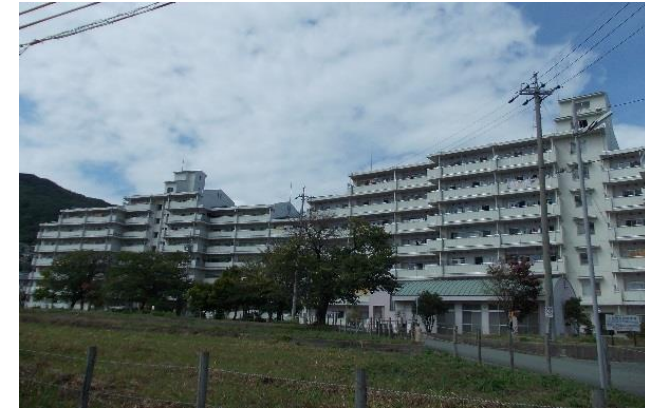
市営住宅 上松東団地 【築23～25年】
