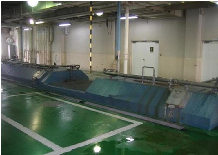
【し尿及び浄化槽汚泥投入場】
