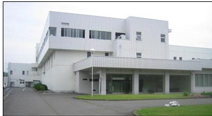
衛生センター 【築33】
