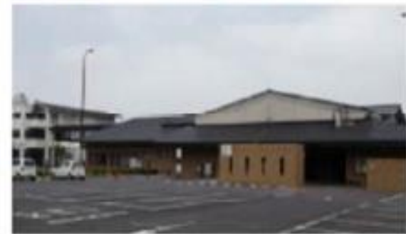
市立図書館の新築工事
