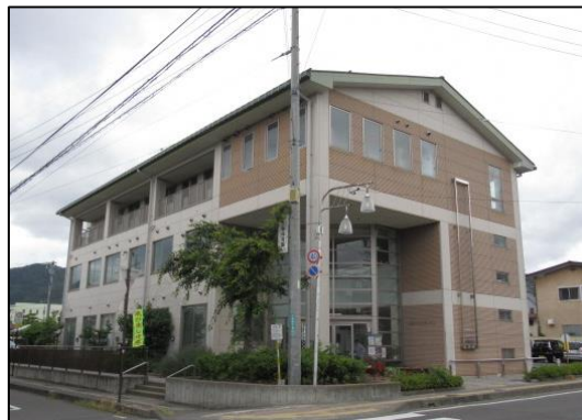
三輪公民館新館【築20年】
