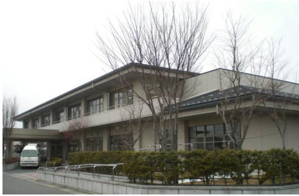
三陽保健福祉センター【築19年】
