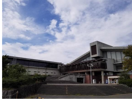
総合体育館 【築38～40年】
