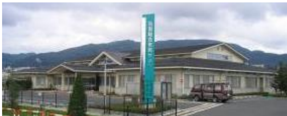
古里総合市民センター(支所・公民館)【築17年】
