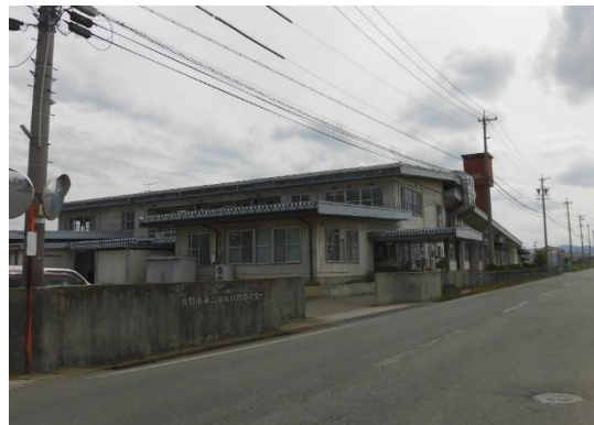
第三学校給食センター 【築40年】
