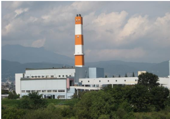
旧清掃センター【築37年】
