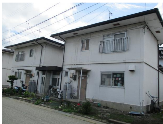
大豆島西改良住宅A棟 外観
