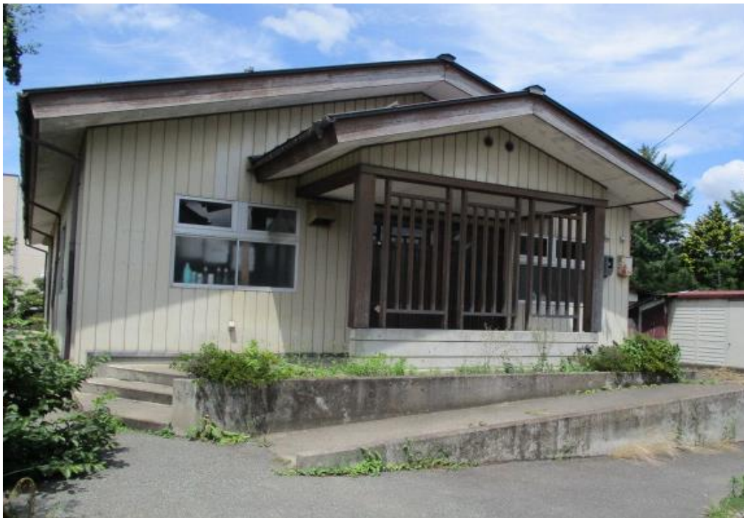
建物東側 正面玄関
