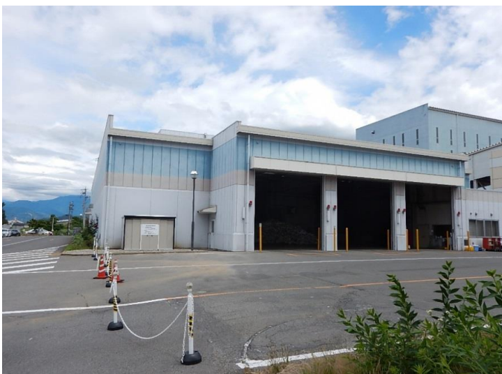
プラスチック製容器包装圧縮梱包施設
