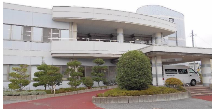
安茂里老人福祉センター、安茂里デイサービスセンター 【築23年】
