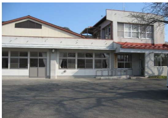
安茂里公民館小市分室 【築41年】
