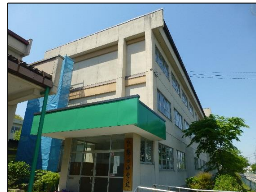
綿内小学校 【築15～46年】
