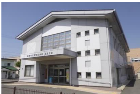
更北公民館稲里分館【築21年】
