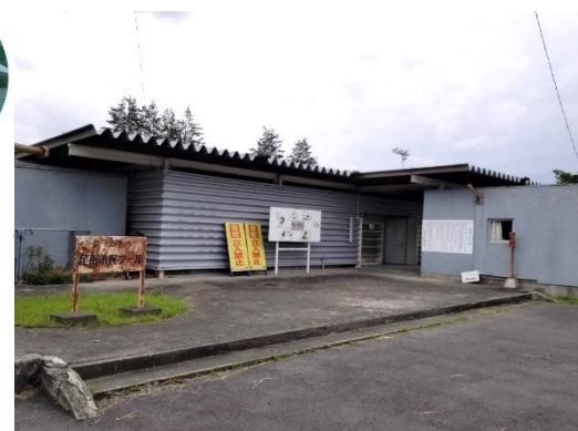
犀南市民プール【築44年】
