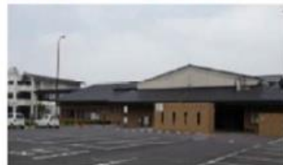
市立図書館の新築工事
