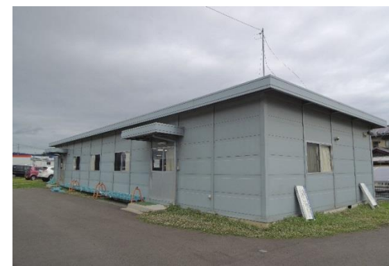
埋蔵文化財センター遺物整理棟【築9年】
