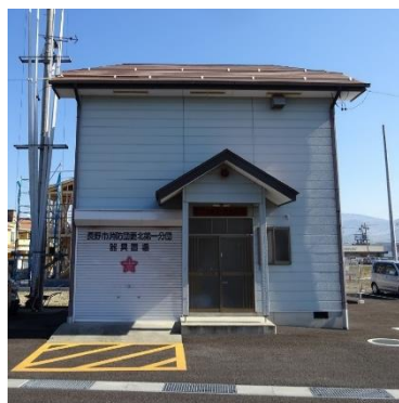
更北第一分団詰所【築24年】
