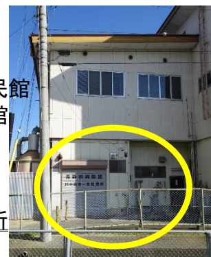
川中島第一分団詰所 【築29年】
