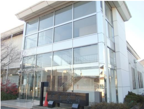
川中島町公民館中津分館 【築31年】
