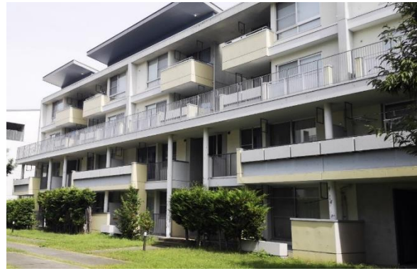
職員住宅 【築20年】
