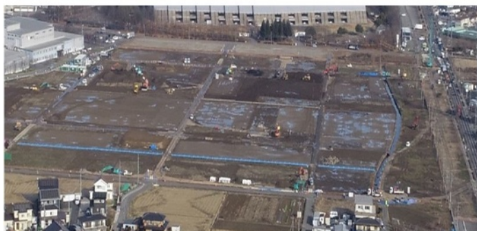
造成中のエムウェーブ南産業団地
