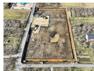
整備中の長沼雨水調整池
