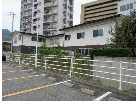
2. 第五地区分館 全景 南側
