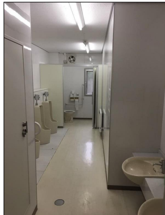
位置: 南校舎 トイレ 撮影日: 平成30年6月11日
