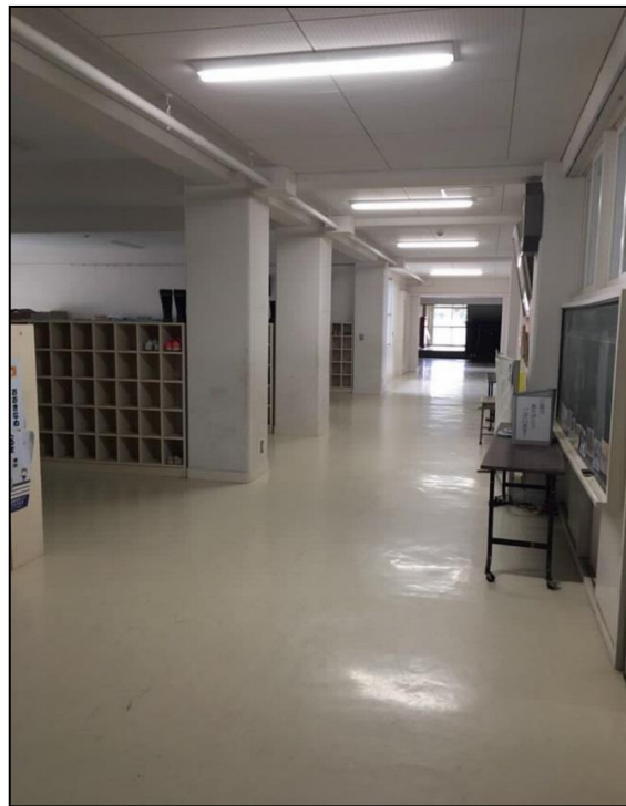
位置: 昇降口棟 廊下 撮影日: 平成30年6月11日
