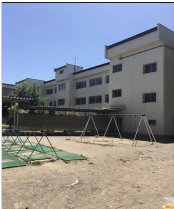
位置: 中校舎 外観 撮影日: 平成30年6月7日
