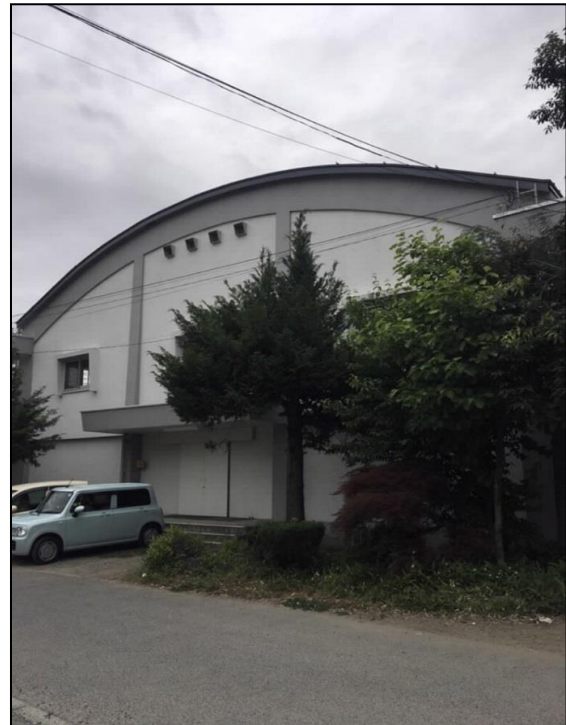
位置：体育館 外観 撮影日：平成30年6月11日
