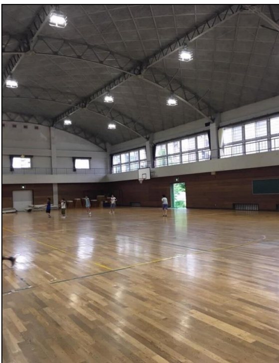
位置：体育館 内観 撮影日：平成30年6月11日
