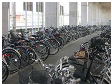
安茂里駅高架下自転車駐車場
