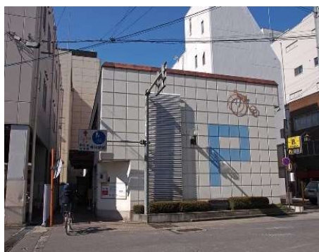
長野駅自転車駐車場
