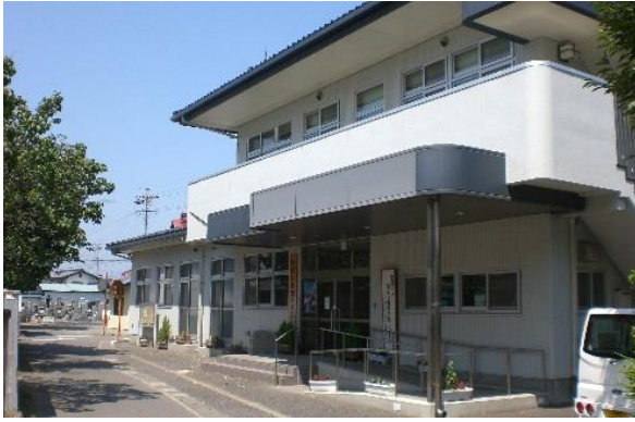
西寺尾分館外観
