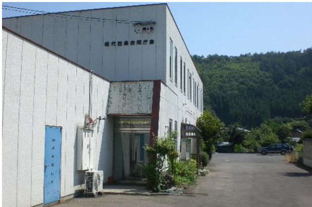
西条分館(2階部分)外観
