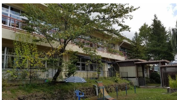
渡り廊下(北校舎～南校舎)
