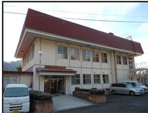
支所・農村環境改善センター
