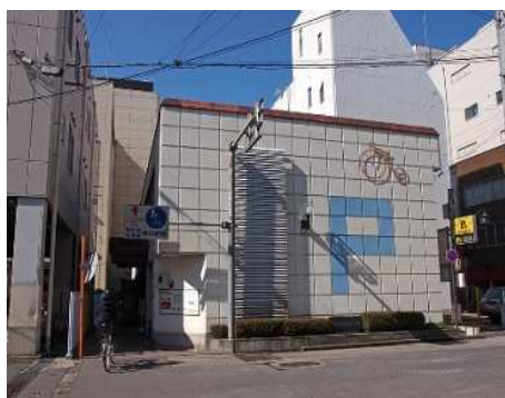
長野駅自転車駐車場
