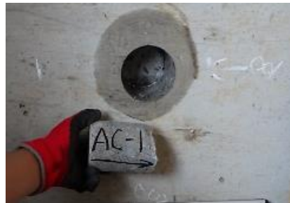
【コンクリート強度試験用コア採取】
