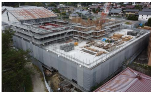
【躯体工事施工中】 令和一年十月撮影
