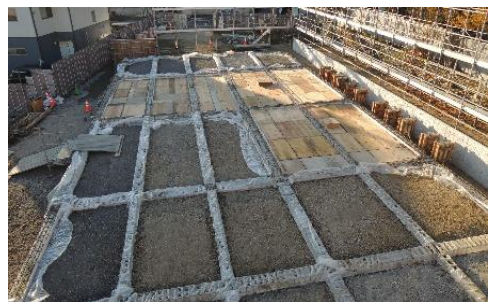
【基礎工事】 令和二年十一月撮影
