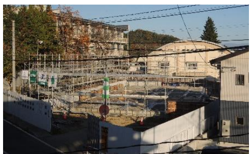
【仮設工事（足場組立）】
