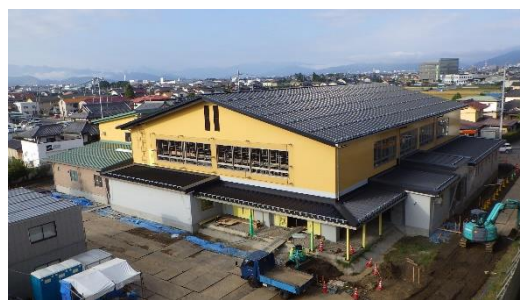
【外構工事施工中】 令和一年九月撮影
