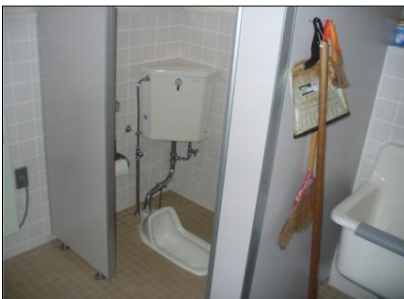
位置: 多目的ホール脇男子トイレ 撮影日: 平成28年3月25日
