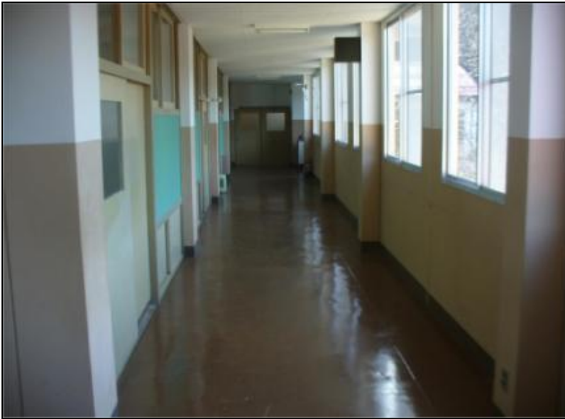
位置：南校舎2階廊下 撮影日：平成28年3月25日
