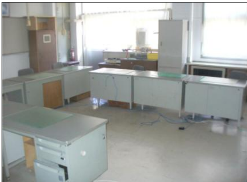
位置: 北校舎1階職員室 撮影日: 平成28年3月25日
