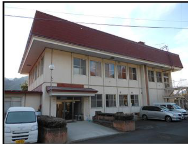
支所・農村環境改善センター
