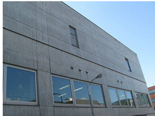
コンクリート打放し（素地）
