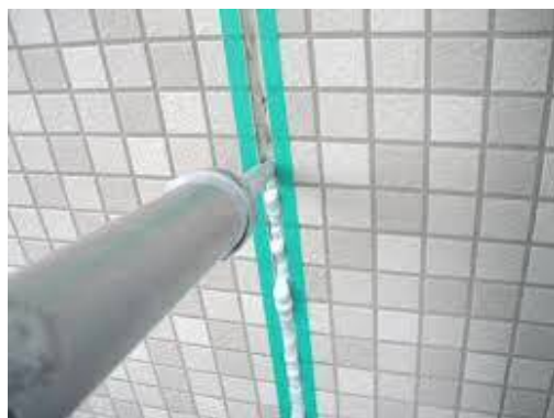
シーリング 施工状況
