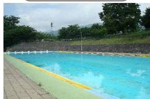
北部市民プール
