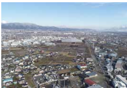
▲造成中のエムウェーブ南産業団地
