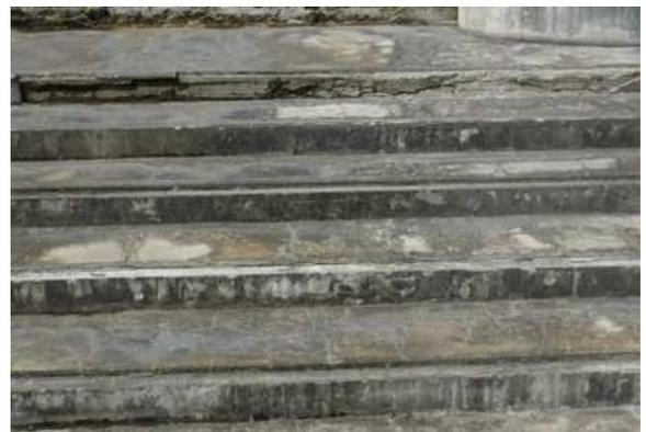
正面階段の劣化(ひび割れ、欠け)
