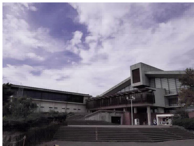
前回の「やまびこ国体」で建設された長野運動公園総合運動場総合体育館（昭和 53(1978)年竣工）
