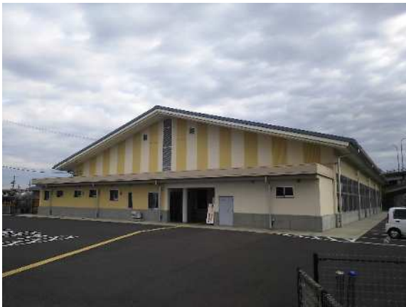
【屋内運動場外観】
