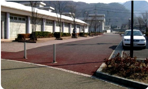
エントランス広場
