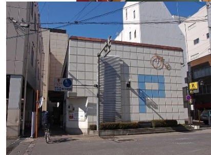
【長野駅自転車駐車場】
