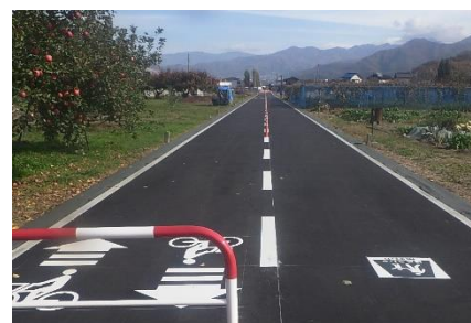
【千曲川新道（綿内北工区）】
