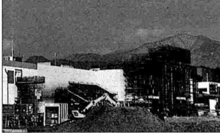
建設中のイオンモール須坂(3月撮影)
