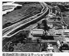
長沼地区河川防災ステーション状況
