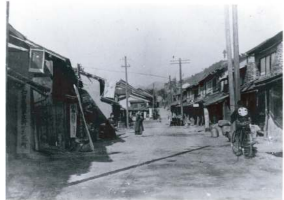
市街地風景 家並みが続く本通りは現在も商店などが建ち並ぶ町のメインストリート
